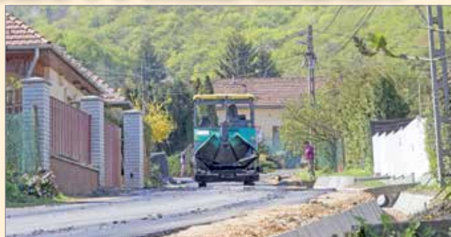
Két réteg aszfaltot kap a Tölgy utca. Fotó: Beregi László
