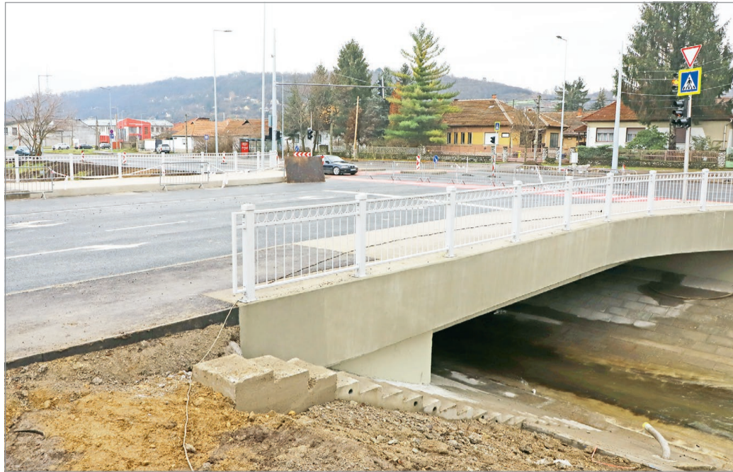
A Thököly utcai híd felújítása és bővítése fontos fejlesztésnek számít a városrész életében. Fotó: M. L.
